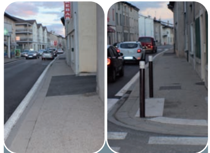
Début 2018 : réfection des trottoirs RD 1084
