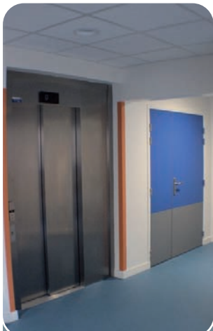
Mise aux normes accessibilités PMR
