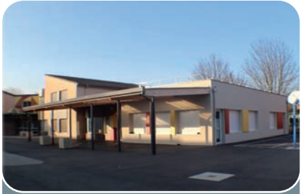
Construction d'un nouveau bâtiment
